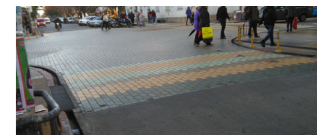
Fig.5 y 6 - Calle elevada a nivel de vereda con marcación en color para disminuidos visuales
