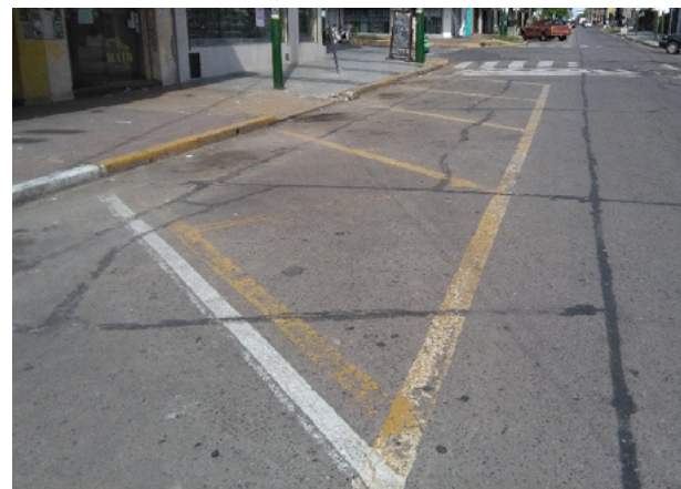
Fig. 12- Espacios para estacionar reservados para personas con discapacidad mal señalizados
