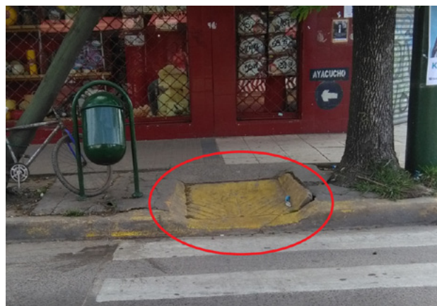
Fig. 1 Rampa con escalón
